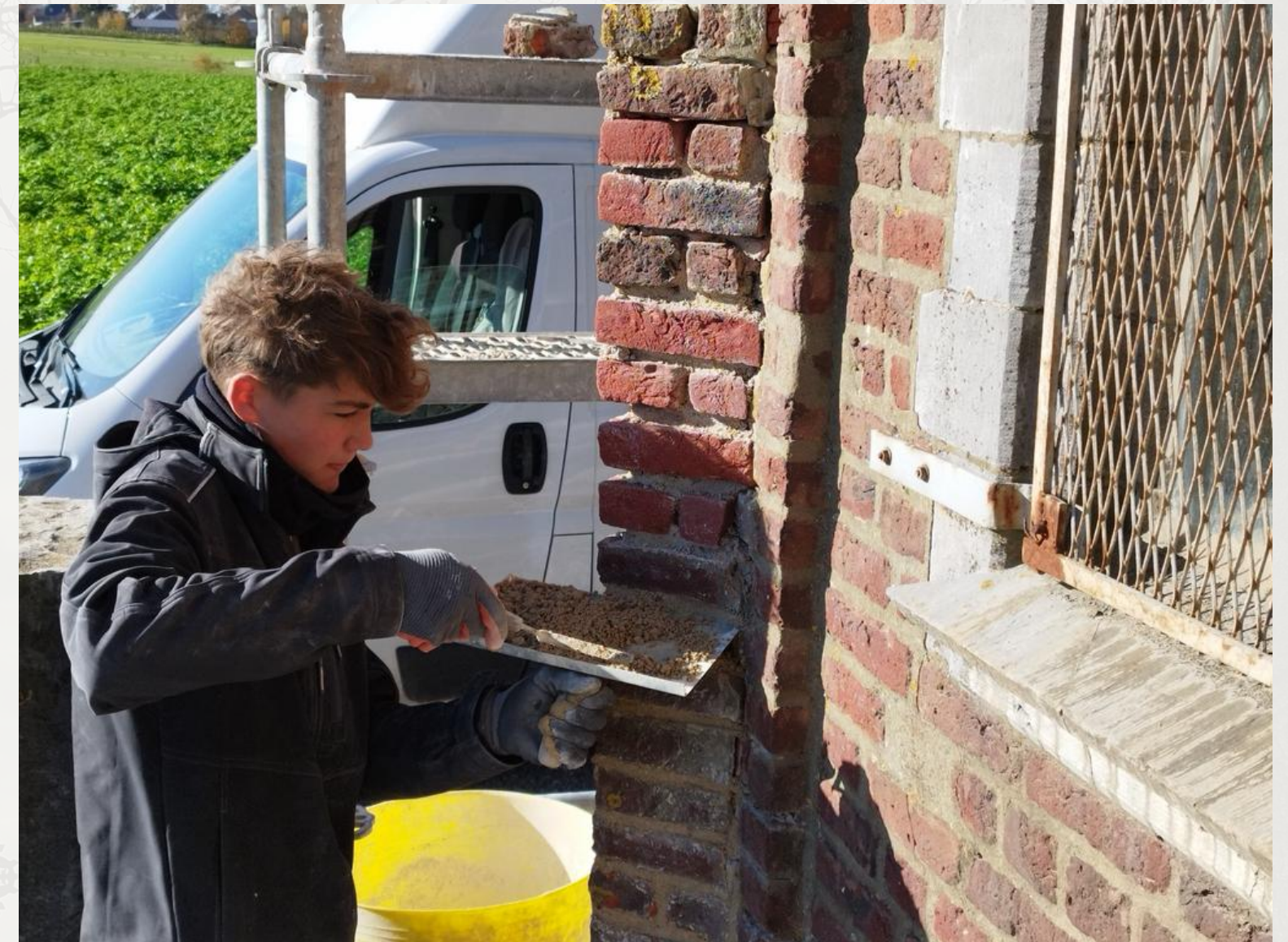
Restauration de la chapelle Notre-Dame de Grâce - Meux Namur
