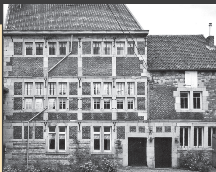
La ferme seigneuriale avant les travaux de 2004 Herenverblijf vóór de werken van 2004 The manor farmhouse before the restoration work of 2004
