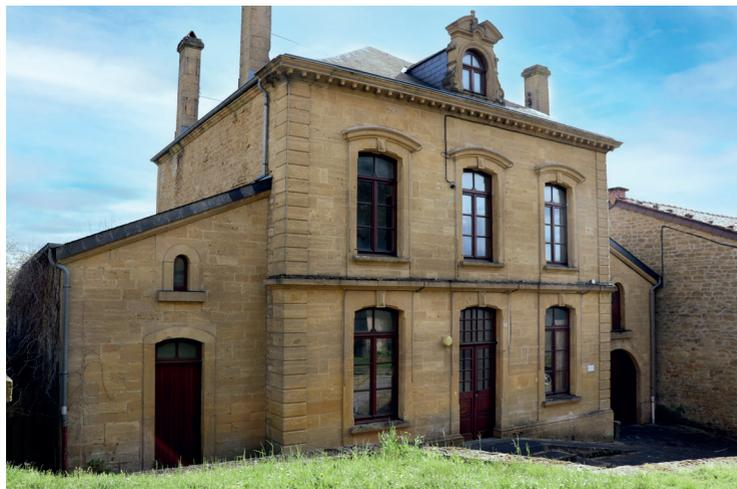
Construit sur le terrain du précédent presbytère, cet édifice en calcaire appareillé date de 1869. Composé d'un **double corps** établi sur un soubassement saillant, il présente deux niveaux séparés par un **bandeau**. La façade est délimitée de part et d'autre par des pilastres à bossage tandis que les fenêtres de l'étage sont marquées par un **larmier bombé** placé au dessus
