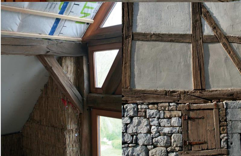
Remplissage des pans-de-bois restaurés en façade à rue et sur le pignon. La technique de remplissage utilisée pour la restauration est inspirée des techniques originales. Le support ligneux est remplacé par des « caissons » remplis de flocons de cellulose, renforcés par un treillis de roseau comme accrochage pour les enduits extérieurs et intérieurs.
