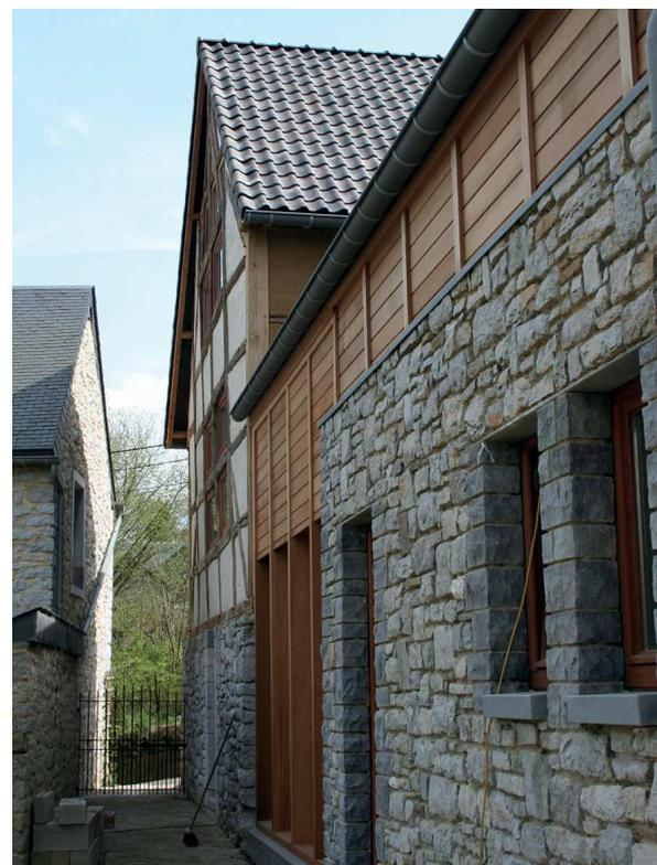
Traitement du volume secondaire marquant la trace du volume initial en pierre dont la pierre est réutilisée. Le pan-de-bois est ici remplacé par une ossature et un bardage réalisé selon les techniques actuelles.
