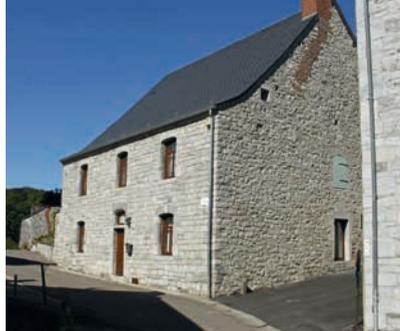
En Callestienne, les constructions en pierre se sont imposées par l'omniprésence du calcaire en sous-sol. Datée de 1777 à l'entrée, cette habitation est bâtie exclusivement en calcaire, des moellons de la maçonnerie jusqu'aux montants harpés et linteaux bombés à clé des différentes fenêtres. Sa volumétrie et sa bâtière à coyau de même que certains détails architecturaux, comme la baie d'imposte à linteau échancré et clé millésimée, lui confère l'allure d'habitation plus cossue.
