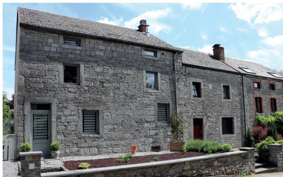
Le volume annexe situé perpendiculairement, sur la gauche, referme la séquence des habitations situées aux n°1, 2 et 3. Le mur gouttereau Sud a probablement été élevé en deux temps : sur la gauche, une première partie aveugle en moellons calcaires sans doute de la 2<sup>e</sup> moitié du 18<sup>e</sup> siècle ; et une seconde partie sur la droite composée de briques, colombage et besaces d'angle en pierres, datant peut-être de la 1<sup>e</sup> moitié du 19<sup>e</sup> siècle.
