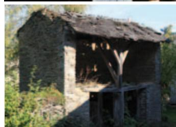
Une **charpente** exceptionnelle, renforcée par deux **aisseliers**, supporte l'ensemble édifié dans la première moitié du 19<sup>e</sup> siècle. Ces pièces de bois placées suivant un angle d'environ 45° participent au maintien de la structure et soulagent l'assemblage de bois. Ce magnifique **témoignage** du mode de vie de nos aïeux est malheureusement en train de disparaître.
